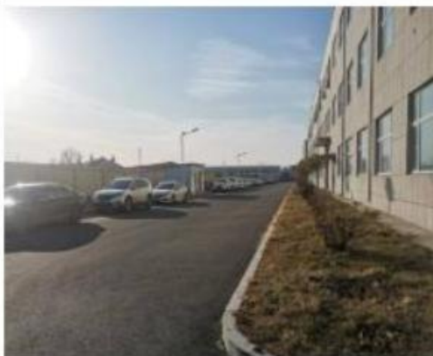
项目所在厂房厂界南侧
